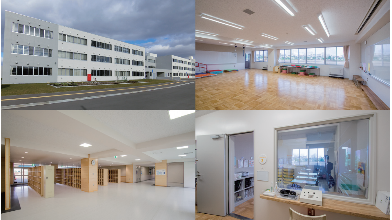
校舎南西側(小学校側)外観。面しているのは6学年の普通教室で、手前側は駐車場を整備。中央は給食搬入用のプラットフォームでその両側に小中それぞれの出入口がある(左上)。小学校特別支援学級のプレイルーム(右上)。小学校の通級指導教室(右下)。中学校の玄関ホールと昇降口、柱や腰壁を木で仕上げ、中庭を背にした明るい場所(左下)
