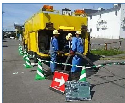
管渠清掃作業の様子
