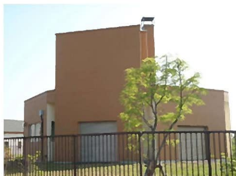
錦岡中継ポンプ場
