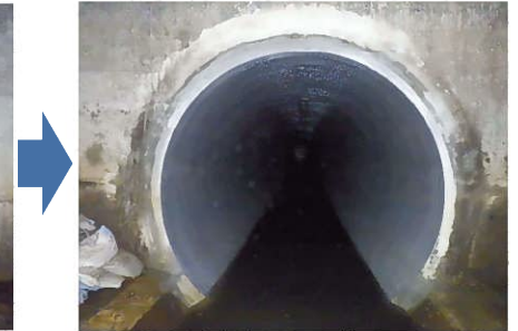
更生工法による更新(更新後)
