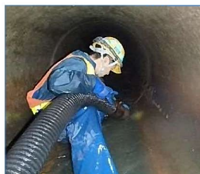
管渠清掃作業の様子(管内)
