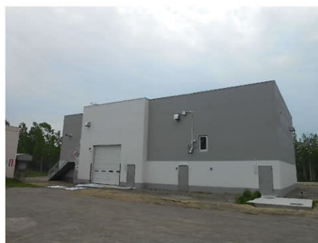
沼ノ端中継ポンプ場
