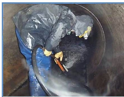
管渠内清掃状況
