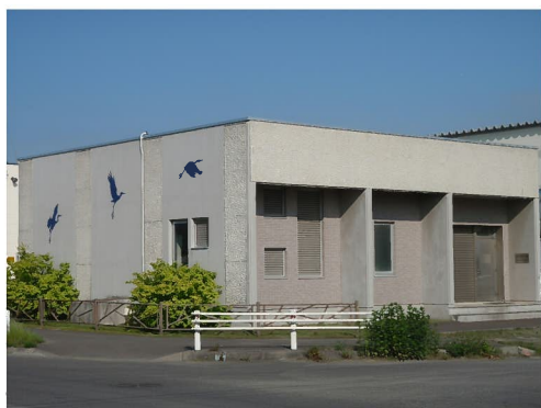
明野中継ポンプ場
