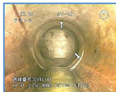
既設管渠の状況(カメラ調査結果)
