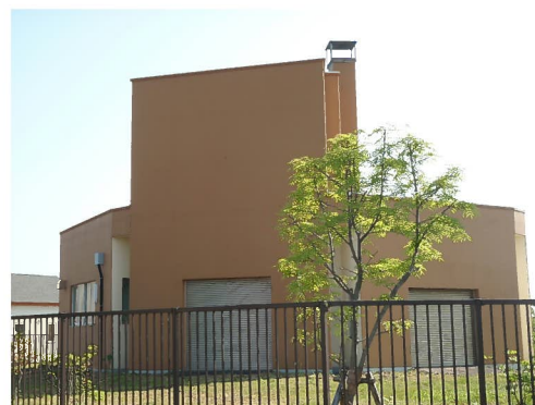
錦岡中継ポンプ場
