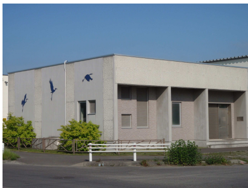
明野中継ポンプ場
