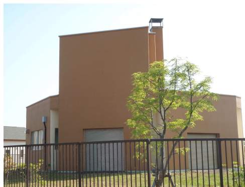
錦岡中継ポンプ場
