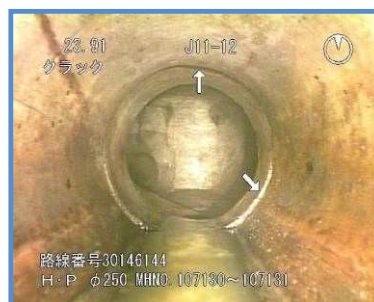
既設管渠の状況(カメラ調査結果)
