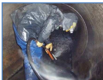
管渠内清掃状況
