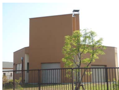
錦岡中継ポンプ場
