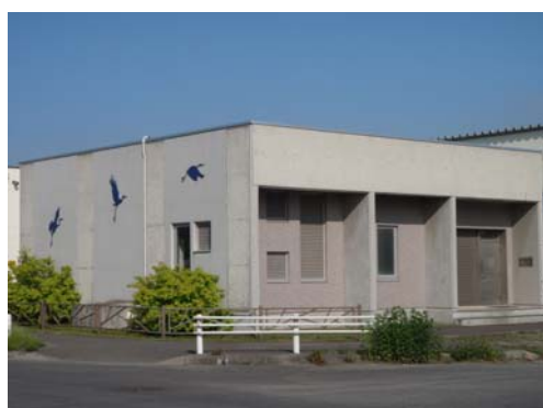
明野中継ポンプ場
