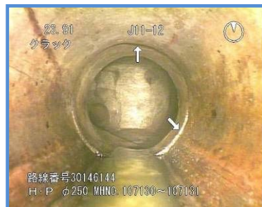
既設管渠の状況(カメラ調査結果)
