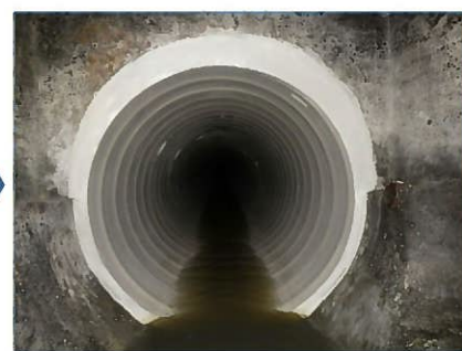
更生工法による更新(更新後)
