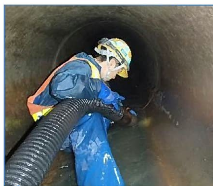
管渠清掃作業の様子(管内)
