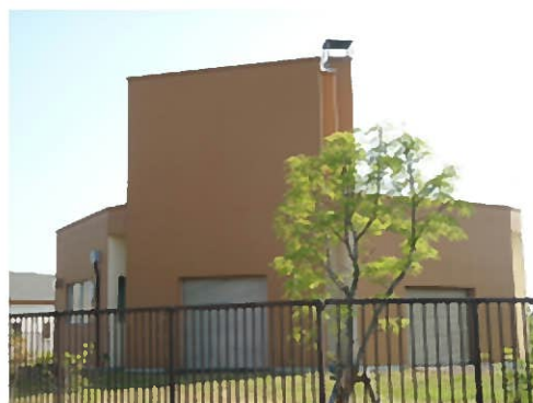
錦岡中継ポンプ場
