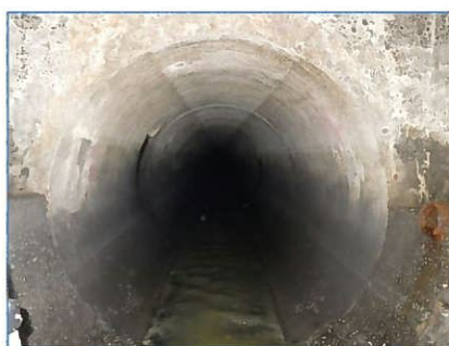
老朽管の状況(更新前)
