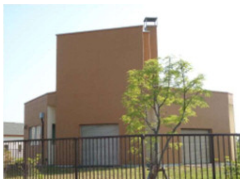
錦岡中継ポンプ場
