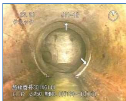
既設管渠の状況(カメラ調査結果)
