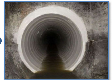
更生工法による更新(更新後)
