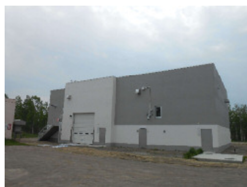
沼ノ端中継ポンプ場
