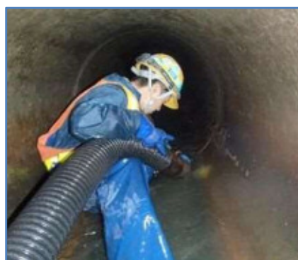
管渠清掃作業の様子(管内)
