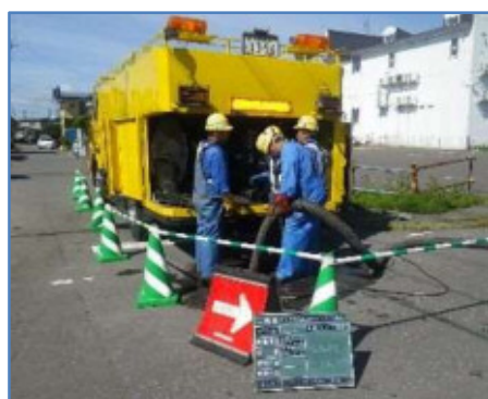
管渠清掃作業の様子
