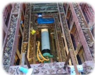
高丘浄水場配水本管改良工事口径 (口径800mm)
