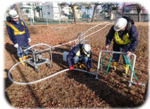
緊急貯水槽を使用した訓練の様子
