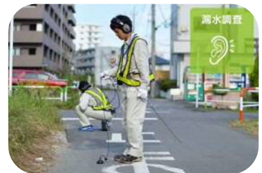
漏水探知機による調査
