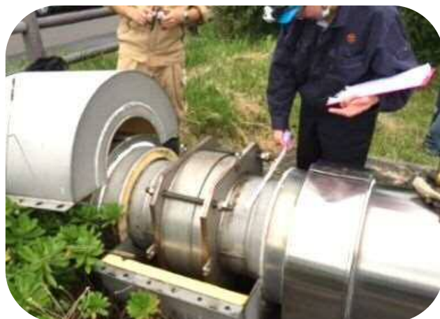
管路の点検作業の様子
