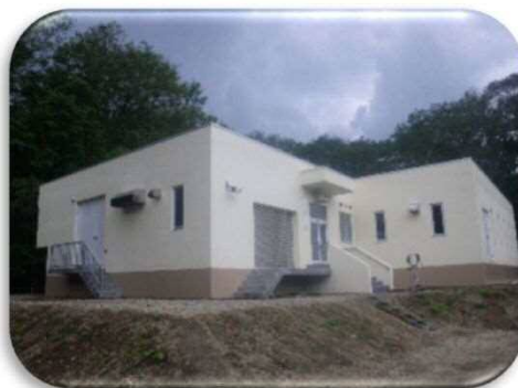
勇振ポンプ場
