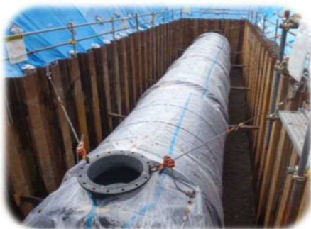
緊急貯水槽設置状況
