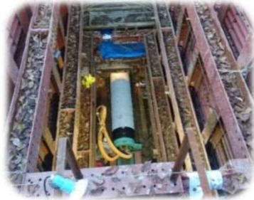
配水本管改良工事
