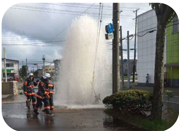
漏水が発生した水道管 (イメージ)
