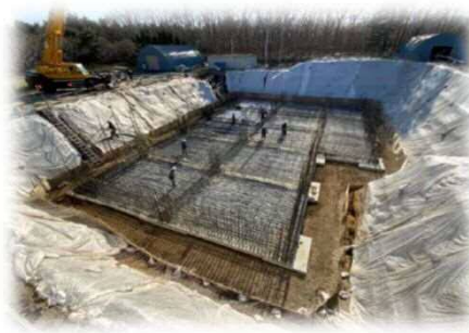
建設中の高丘浄水場新管理棟 (令和3年4月現在)
