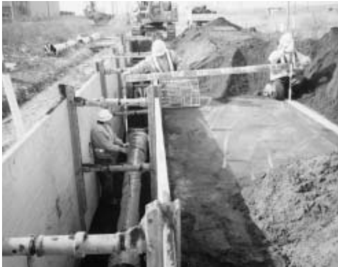
配水管布設工事
