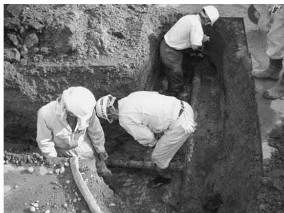
漏水復旧工事のようす
