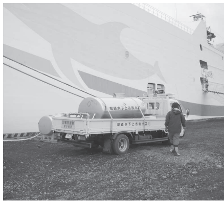
フェリーへの給水作業風景 高い所への給水なので小型ポンプを使用しました
