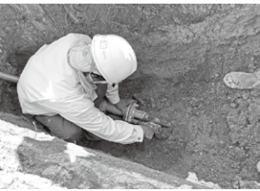
水道管の復旧
