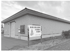
緊急災害対策用貯蔵庫 (日の出町)
