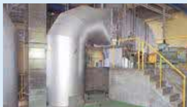
⑧ 誘引通風機 排ガスを、えんとつに送るための機械です。
