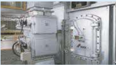
③ 焼却炉 850℃～950℃の高い温度で、ごみを燃やします。
