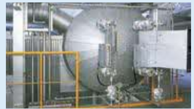
④ ボイラ ごみを燃やして発生する熱を使って、蒸気をつくります。
