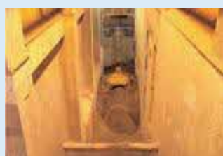
⑪ 灰ピット/灰クレーン ごみを燃やして出た灰をためて、クレーンでつかみ、トラックにつめます。この灰は、沼ノ端埋立処分場へはごびます。
