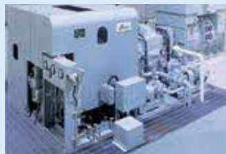
⑤ 蒸気タービン発電機 ボイラでつくられた蒸気を利用してタービンを回し、電気をつくります。
