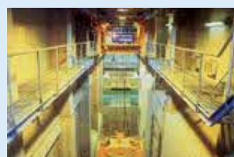
⑪ 灰ピット/灰クレーン ごみを燃やして出た灰をためて、クレーンでつかみ、トラックにつめます。この灰は、沼ノ端埋立処分場へはごびます。
