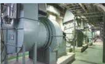
⑩ 押込送風機 ごみを燃やすために必要な空気を、 しょうきゃくろ 焼却炉へ送る機械です。
