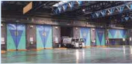
① プラットホーム 集められた燃やせるごみは、ここから入れます。
