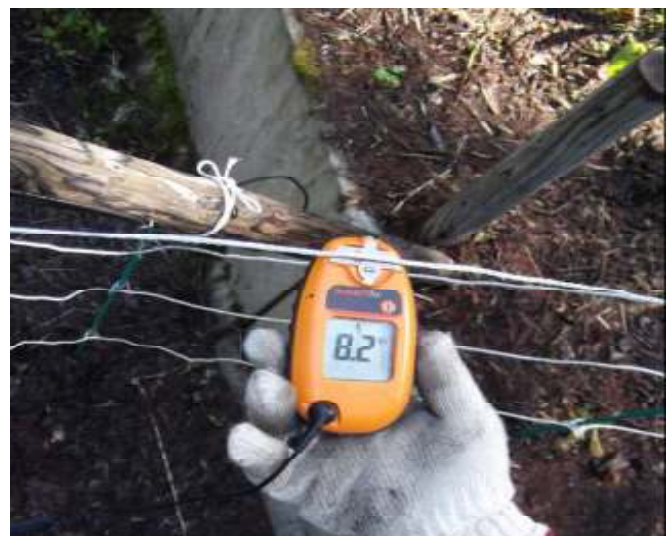
電圧確認中（8,200 ボルト）
