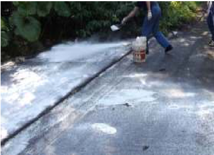
左側上部の空間が獣道（進入経路）
