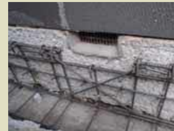
③ コンクリートで基礎を補強
