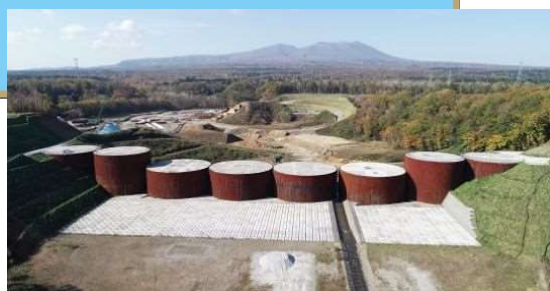
覚生川2号砂防堰堤
