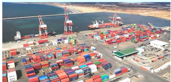
苫小牧国際コンテナターミナル
