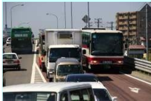
国道276号 緑跨線橋
