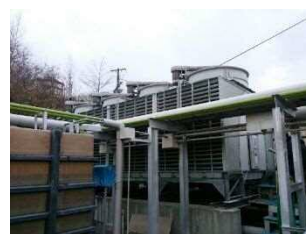
ハイランドスポーツセンター 屋外リンク冷却設備の更新
