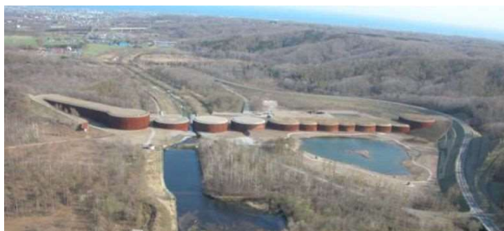
錦多峰川2号遊砂地 (山側より海を望む)
