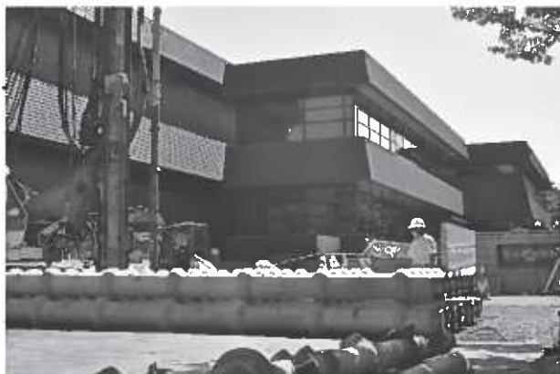
ただいま工事中…
