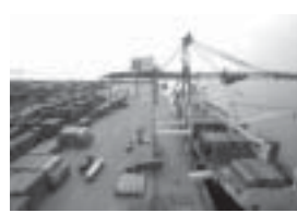
▲国際コンテナターミナル
