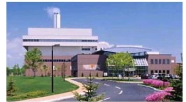
沼ノ端クリーンセンター 平成11年3月竣工 105t/日×2炉 破碎施設あり
