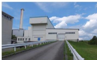
糸井清掃センター(2号炉) 昭和57年8月竣工 (建物は昭和47年建設) 200t/日×1炉
