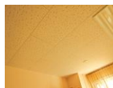
天井ボード (レベル3みなし)
