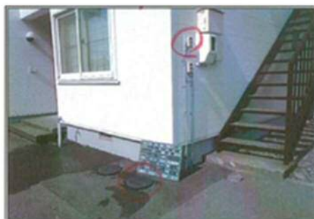
メーター設置完了(開発行為箇所も撮影すること)
