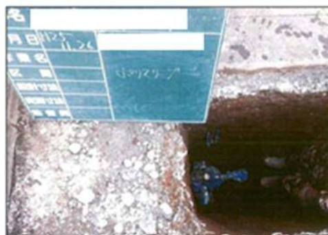
ホリスリーブ取り付け(既設再利用・開発行為は除く)
