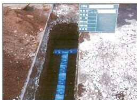
標示シート設置
