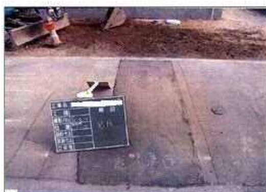
分水閉止完成
