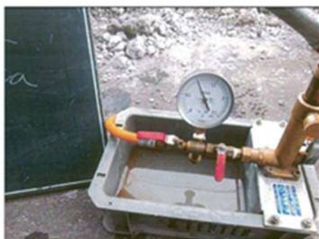
圧力テスト・分水～止水
