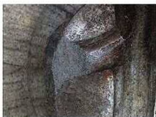
モルタル詰め完了
