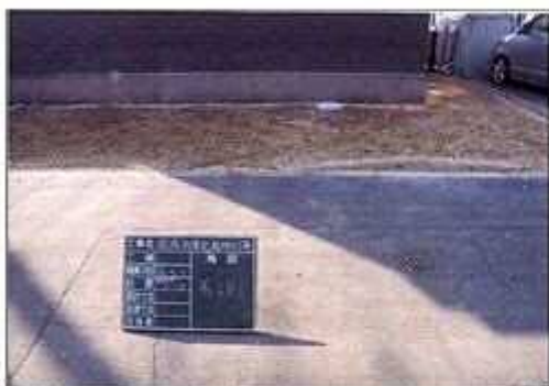
分水閉止着工前
