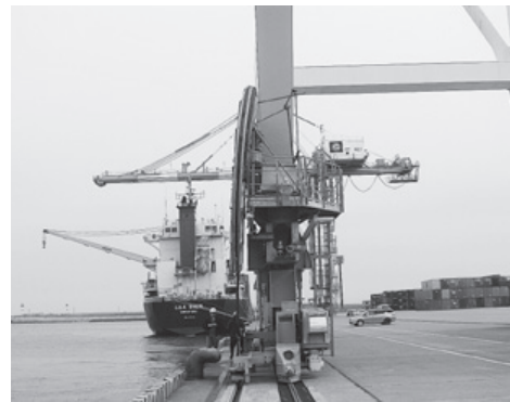
コンテナ船の衝突被害状況
