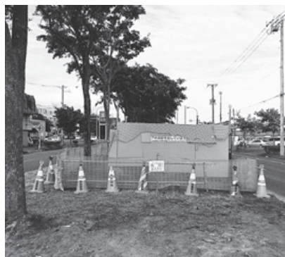
工事が始まった陥没箇所
