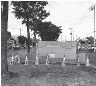
工事が始まった陥没箇所
