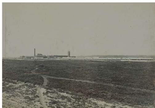
完成した王子製紙苫小牧工場 明治43(1910)年
