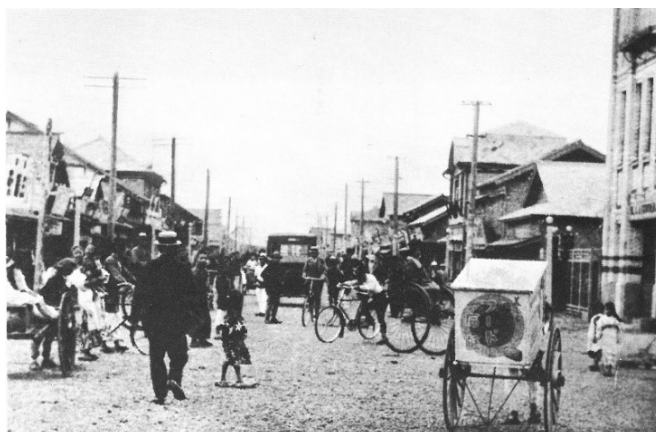
にぎわう大通り 現国道 36 号新川通交差点西側（大正 15 年頃） 荷車、徒歩、自動車、自転車、人力車などが混在している
