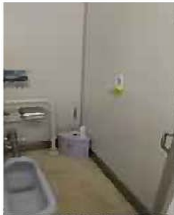
1階トイレ個室
