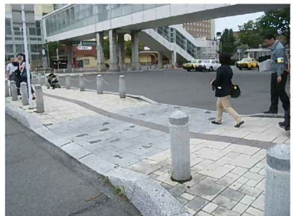
輝度比が確保されていない誘導ブロック
