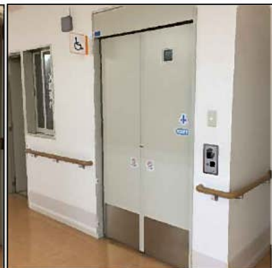
身障者用トイレは手をかざすと開く自動ドア
