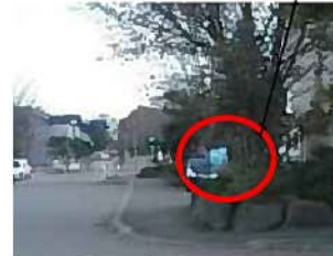
幅が 260cm しか確保されていない (国交省で示している設計標準値は 350cm 以上)
