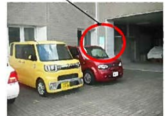
幅が 260cm しか確保されていない (国交省で示している設計標準値は 350cm 以上)
