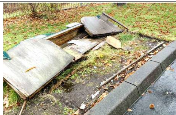
強風により倒壊した木製ごみ箱
