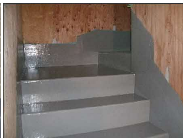
写真 1.2.2 屋外階段の 塗膜防水施工の事例
