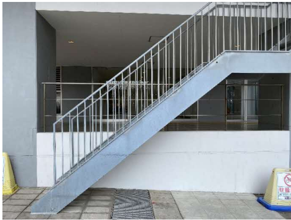
写真 1.3.4 塗料による防錆措置の事例
