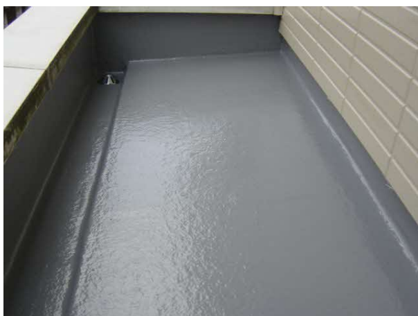
写真 1.2.1 FRP系塗膜防水の 施工の事例
