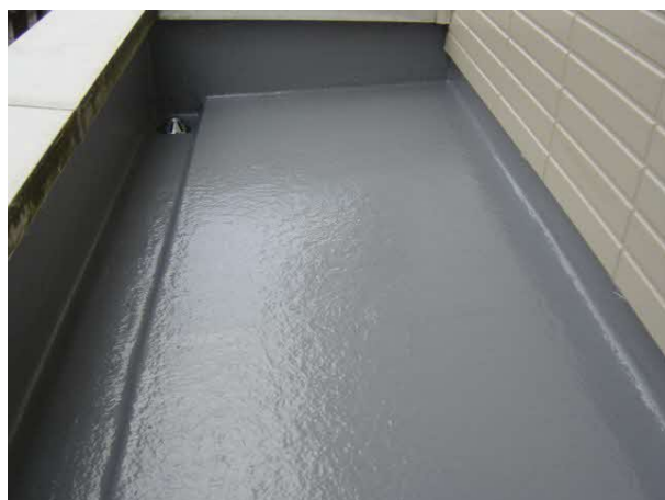
写真 1.2.1 FRP系塗膜防水の 施工の事例
