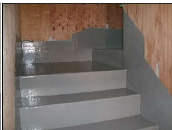
写真 1.2.2 屋外階段の 塗膜防水施工の事例
