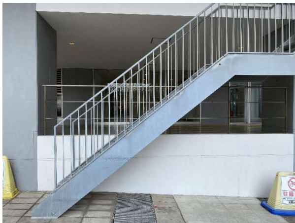
写真 1.3.4 塗料による防錆措置の事例
