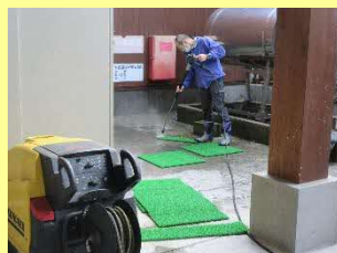
高圧洗浄機で清掃中
