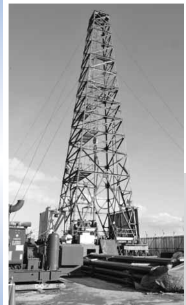
実証試験の本格的始動と もいえる萌別層観測井の 掘削開始（H25（2013） 年1月）
