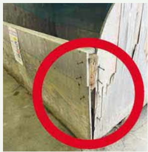
②ごみステーションの破損
