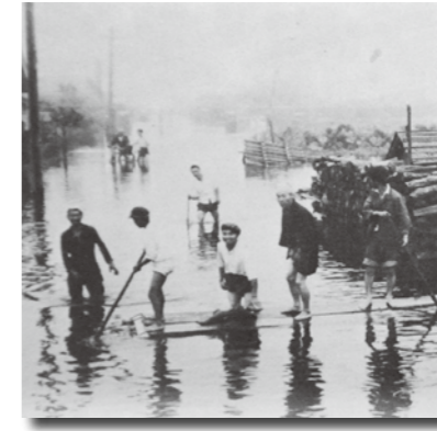
昭和25年の大水害の様子（緑町付近）
