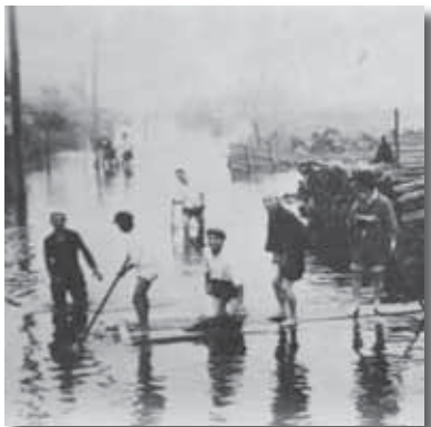
昭和25年の大水害の様子（緑町付近）
